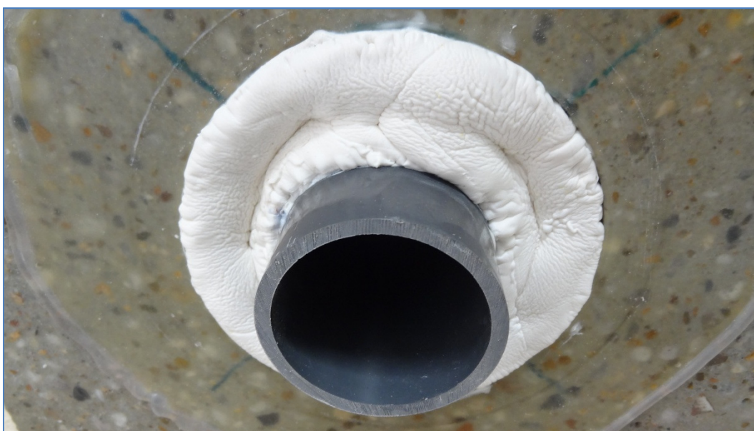
Foto 5. Aanzicht bijna volledig hersteld PU mastiek na enkele uren
