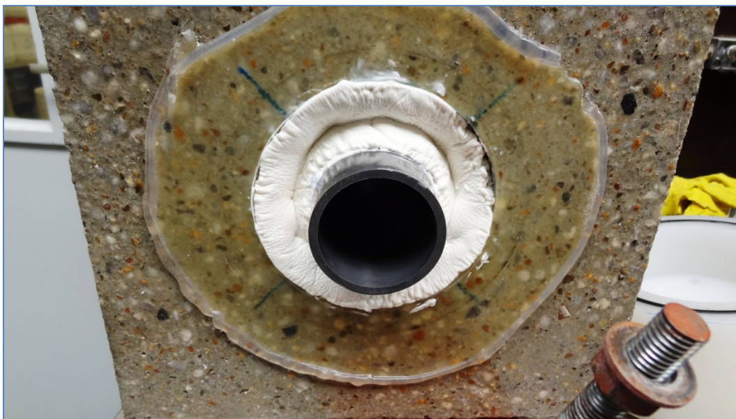
Foto 4. Aanzicht vervorming PU mastiek na belasting met 1 bar overdruk met water
